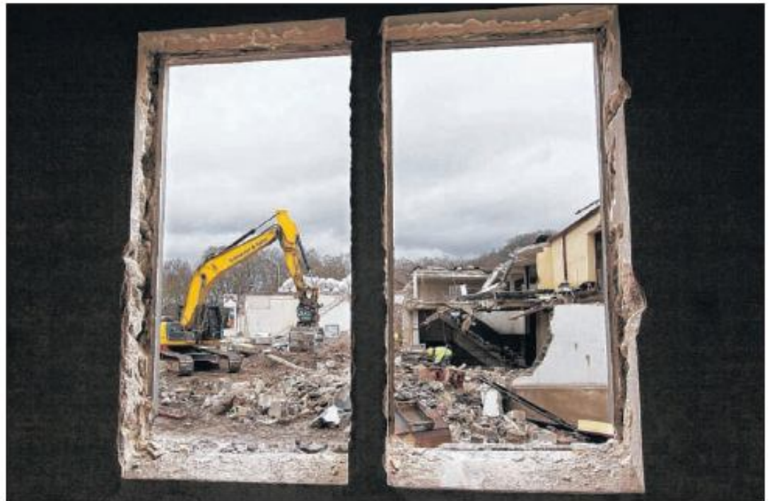
Fenster mit Aussicht auf Verwüstung: Ein Bagger reißt das Reifen-Wenger-Gebäude ab.
