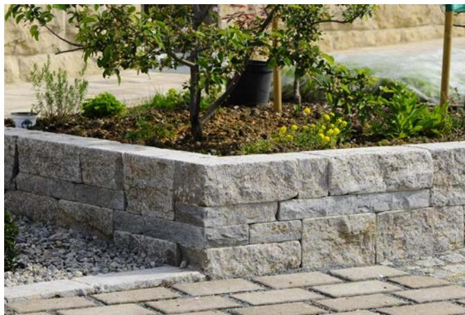
Mit einer Einbandtiefe von ca. 10 cm wird das **Systemmauerwerk 1** als Verblendsteine verwendet. Einen ganz besonderen Charme erhalten unansehnliche Mauern oder Wände durch den natürlichen Charakter der Muschelkalkverblendsteine.
