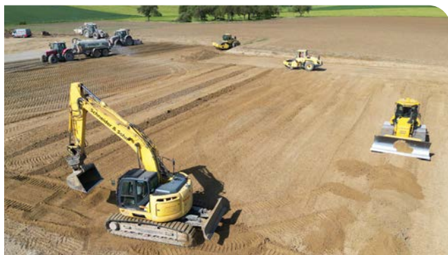
Erarbeiten mit Bodenverbesserung
