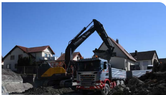
Baugrubenaushub für Tiefgarage
